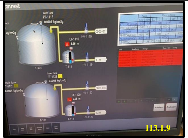
第 1 座儲槽 氮氣封存監控
