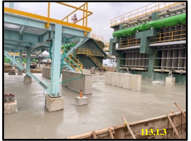
地坪混凝土澆置
