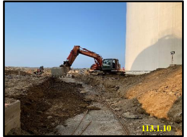
第 2 座儲槽 環狀水溝開挖
