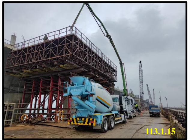
彎管平台第二層混凝土澆置
