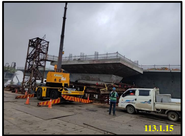
彎管平台支撐型鋼拆除
