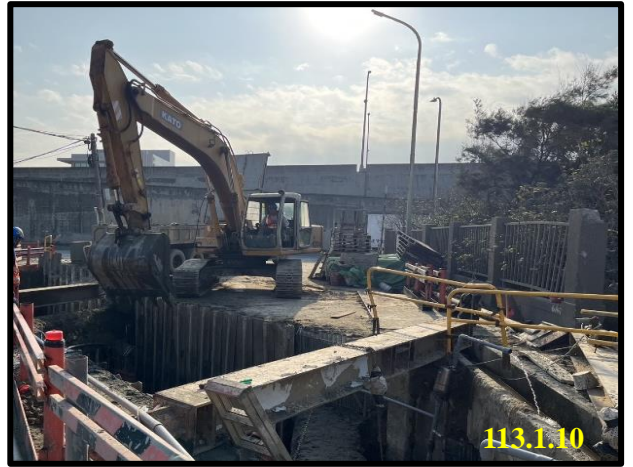
電廠一路北段管溝開挖
