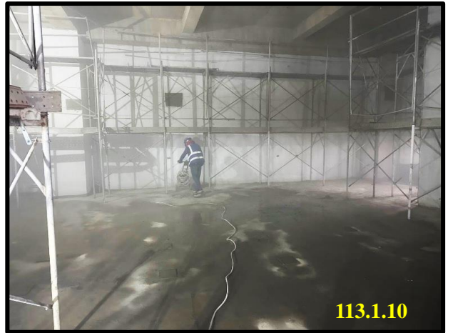
製程變電站 3 樓地坪研磨
