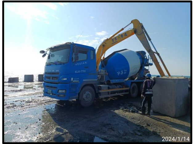
沉箱(#57)回填砂封頂
