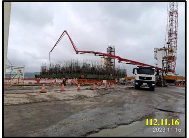
沉箱 (BE-66)混凝土滑模澆置
