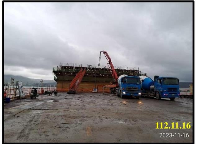
沉箱 (BE-67)混凝土滑模澆置
