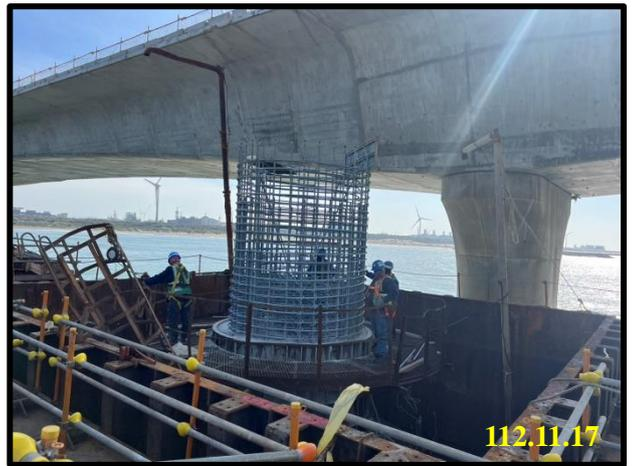
墩柱第 4 層鋼筋綁紮
