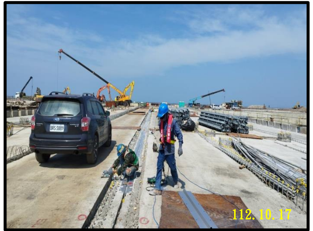
B1-B6 角鋼伸縮縫施作
