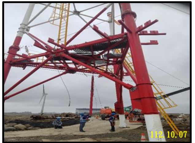
STR-601 排放塔鋼構安裝
