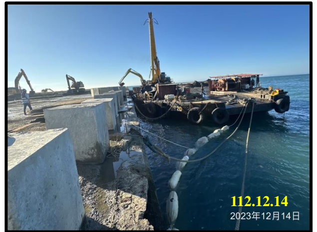
沉箱(#56)回填作業
