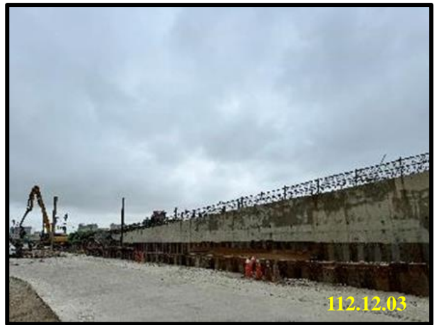
儲槽區海水管打樁
