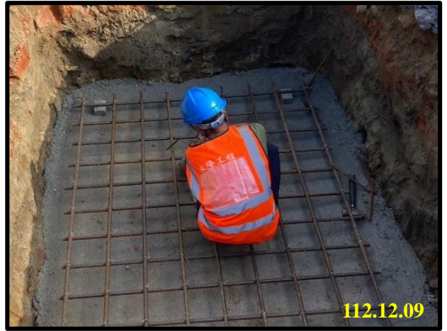
隔離站鋼筋綁紮
