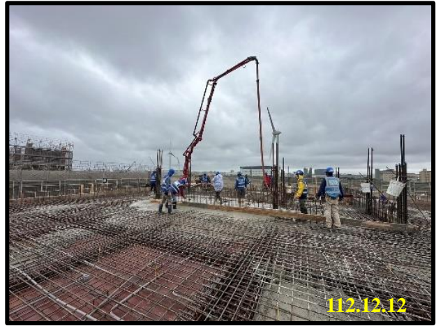
主變電站樓頂層梁版混凝土澆置
