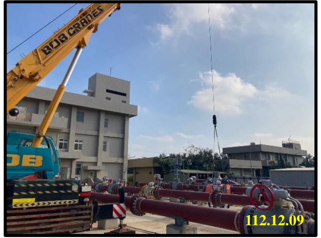
配氣站管件設備安裝
