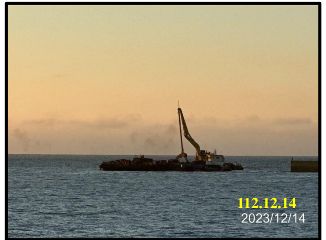
沉箱(#66~#67)塊石整平作業
