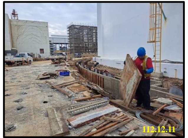
第 2 座儲槽 東側水溝鋼筋模板組立
