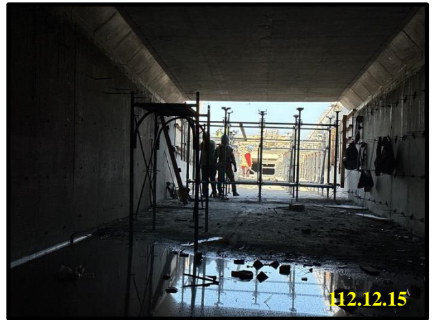
B25 箱涵頂版支撐架搭設
