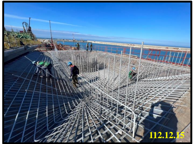
彎管平台鋼筋綁紮
