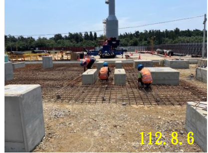
配氣站地坪鋼筋施作
