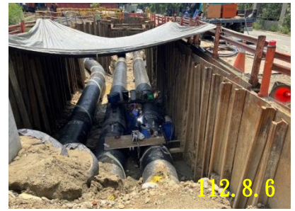
環場路管線銲接作業
