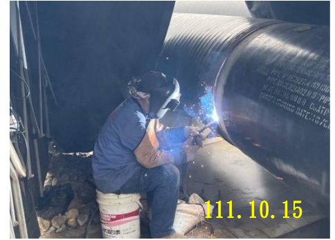
大潭北路管線銲接
