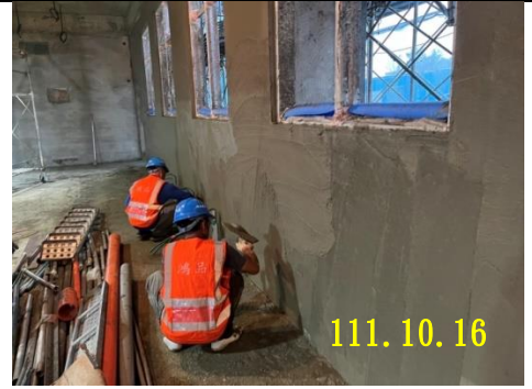
控制室泥作內牆粉刷
