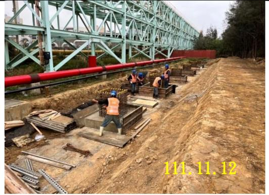
計量站管墩鋼筋綁紮
