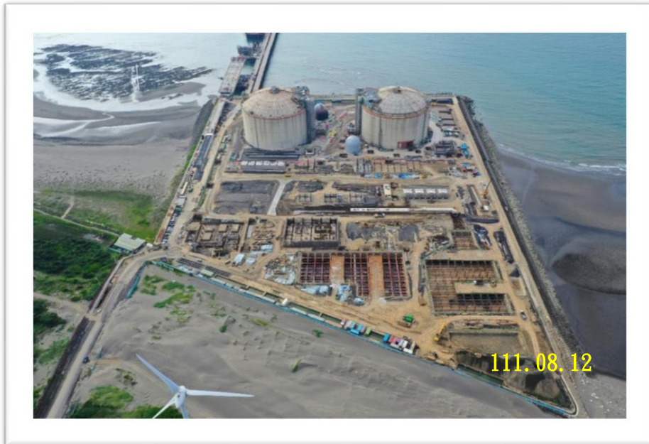
中油公司第三座 LNG 接收站施工空拍圖
