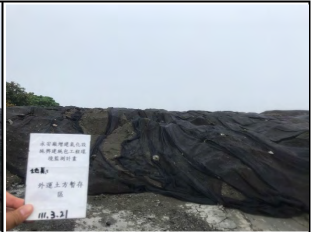
日期：111.03.21 地點：外運土方暫存區
