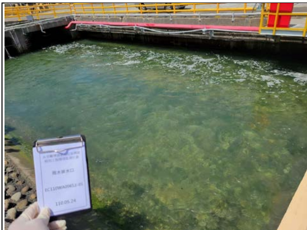
日期：110.05.24 地點：雨水排水口
