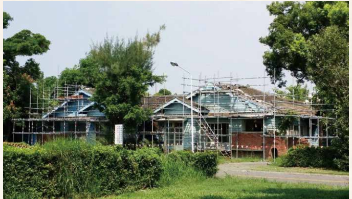
▲宏南市定古蹟進行防護修繕工程(照片/黃文賢提供)。
