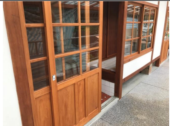
修復完成內部現況圖 1
