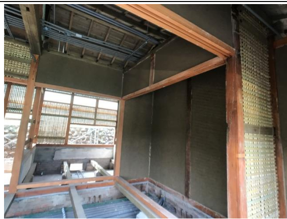
修復中內部現況圖
