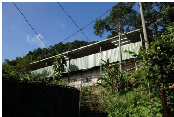
102 年緊急防護工程裝上鋼棚架外觀圖
