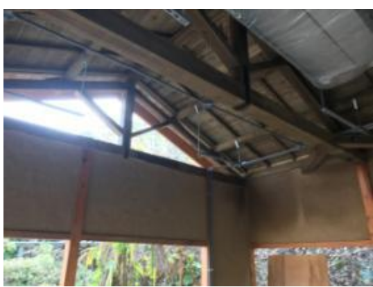
修復中內部現況圖
