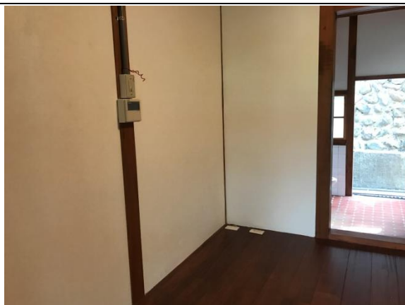
修復完成內部現況圖 2
