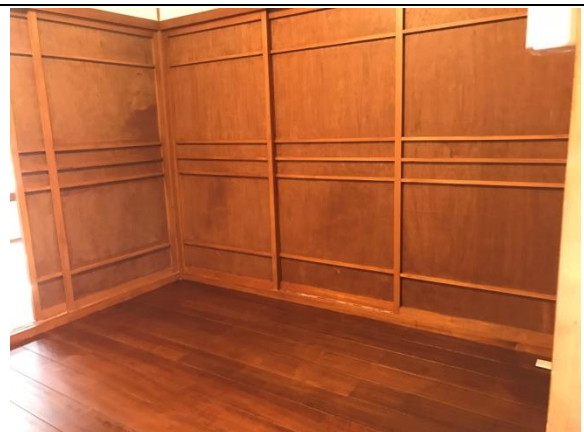
修復完成內部現況圖 3
