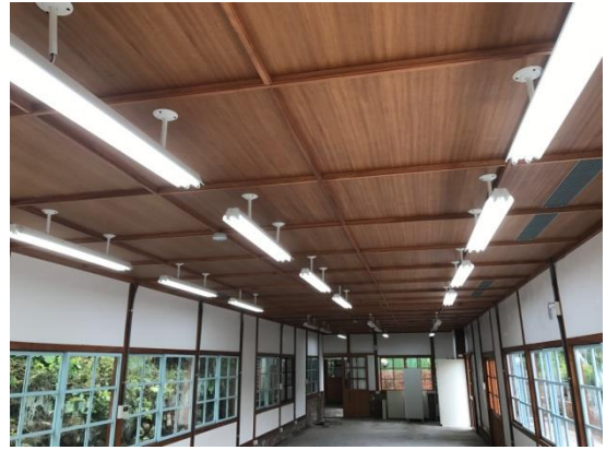
修復完成內部現況圖 4
