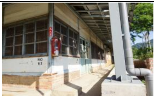
102 年緊急防護工程裝上鋼棚架內部圖
