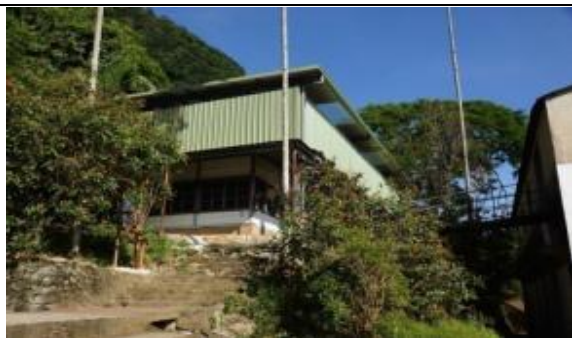
102 年緊急防護工程裝上鋼棚架外觀圖
