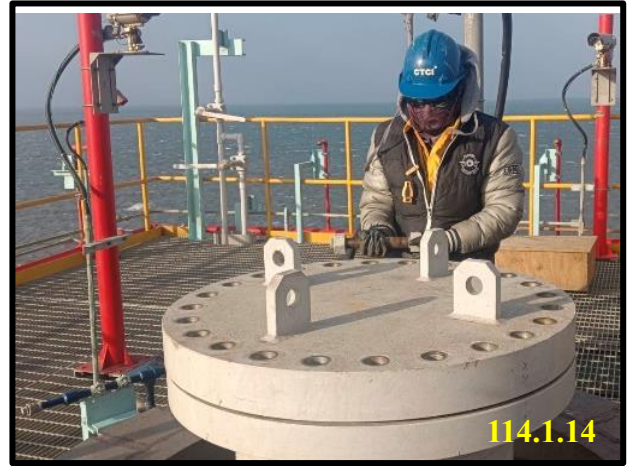
第 1 座儲槽 PUMP 缺失改善
