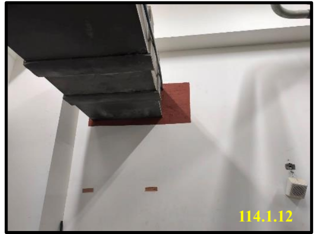
辦公大樓防火填塞施作
