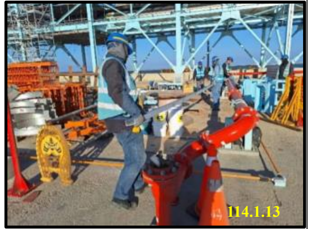
電纜支撐架安裝
