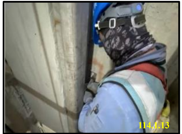
導軌安裝調整
