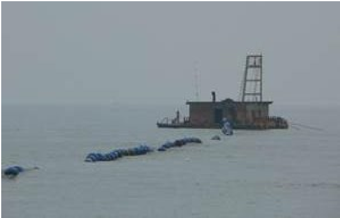
圖 178、永安漁港機械清淤工法案例(上圖)與環評報告水力清淤工法(下圖)實際案例。
