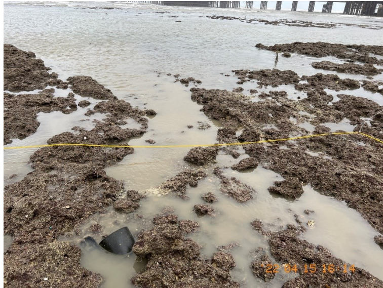
圖 181、實施清沙後現場照，圖中泥水部分為利用水柱噴起區域
