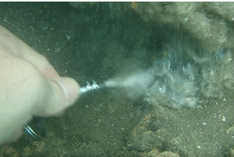
圖 186、氣泡射流防淤現場施作流程
