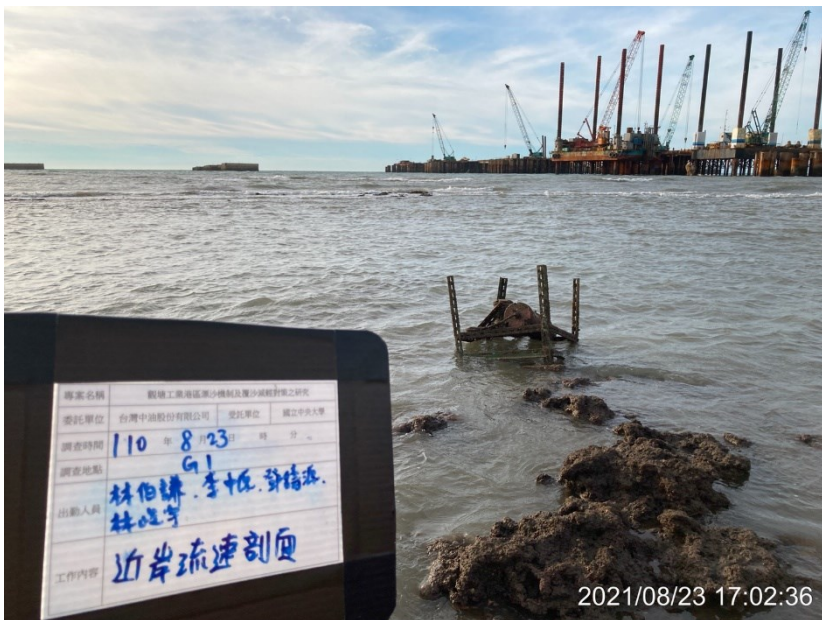
圖 32、G1 區第二次(110/6/24 ~ 110/8/23)潮波流儀佈放現場照片 (上圖:設備佈放, 下圖:設備回收)
