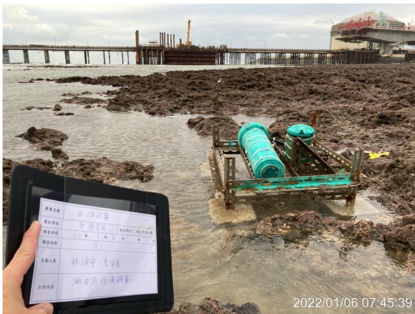
圖 34、G1 區第四次(110/11/9~111/1/6)潮波流儀佈放現場照片 (上圖:設備佈放, 下圖:設備回收)
