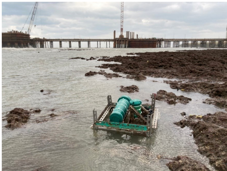
圖 29、G1 區潮波流設備器現場照片
