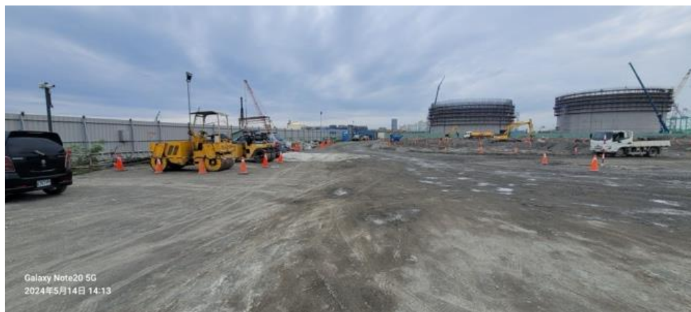
圖 2.2 工程現地狀況 ( 113 年 05 月 14 日 )
