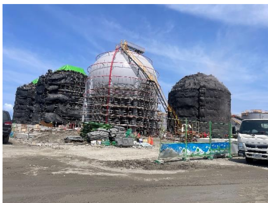
說明：13 座球型油槽組立及周邊管線系統
