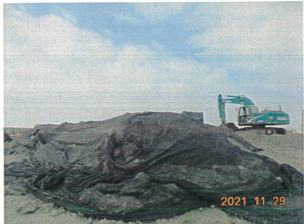
2.土方/砂石堆置處覆蓋防塵網
