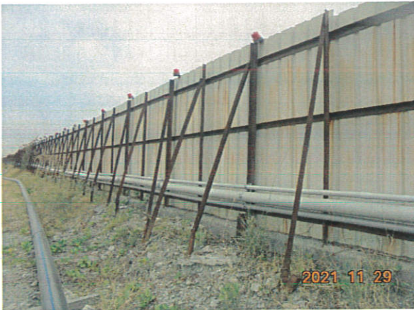
1.設置施工圍籬
