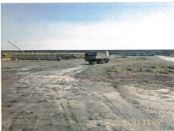
3.減少施工車輛造成揚塵
