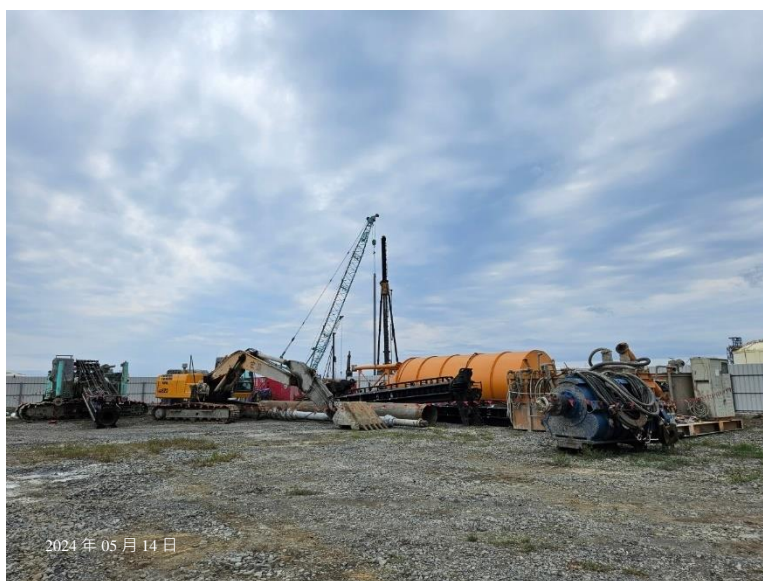
圖 2.2 工程現地狀況 (113 年 05 月 14 日)
