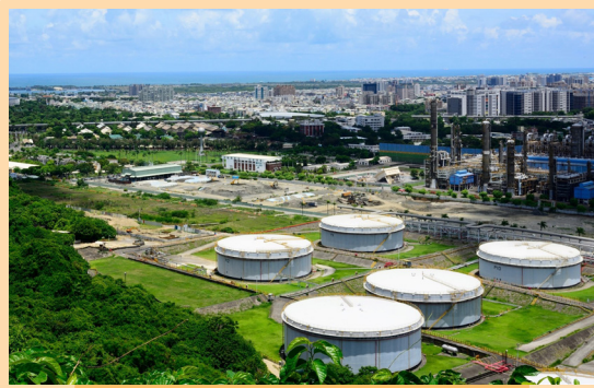
圖 1、五輕拆廠前及中核整治照片
