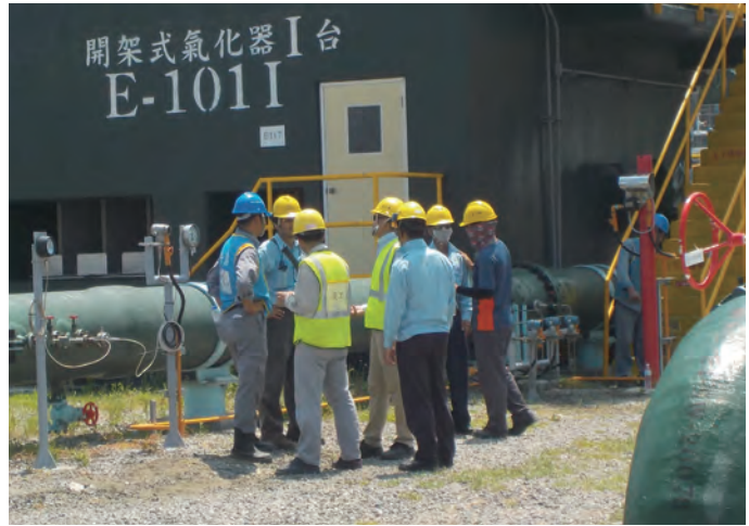
▲台中廠二期投資計畫，氣化設施(ORV)試俾施工。 (照片提供/液工處張義程)
