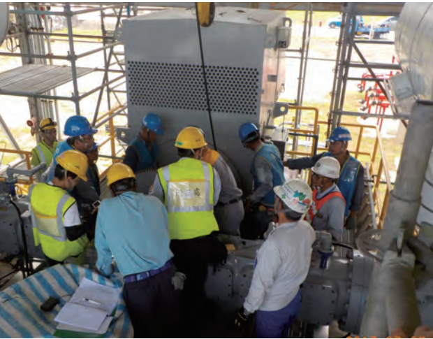
▲台中廠二期投資計畫，安裝BOG壓縮機施工。 (照片提供/液工處張義程)
