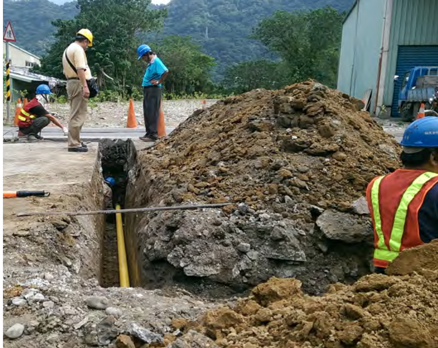
天然氣管線敷設處若遇施工，會派員至現場會勘並警戒，防止管線遭外力破壞。
