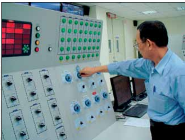
▲張世壩工場長將裂解爐操作模式選擇開關轉到「Run」的位置。
