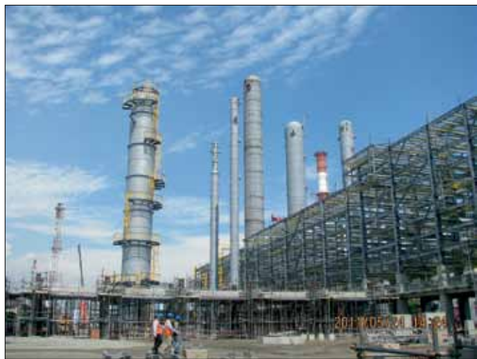
▲進行中的新三輕工場裝建工程。
