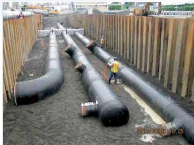
▲新三輕工場地下管線埋設工程。
