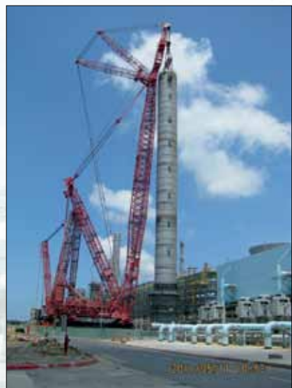
▲以全台最大的 2,000 噸吊車進行吊裝作業。
