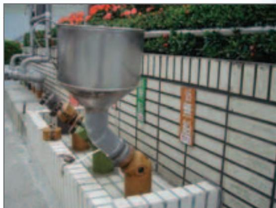
▲ 圖2 承接油料之漏斗置於卸油口之照片。
