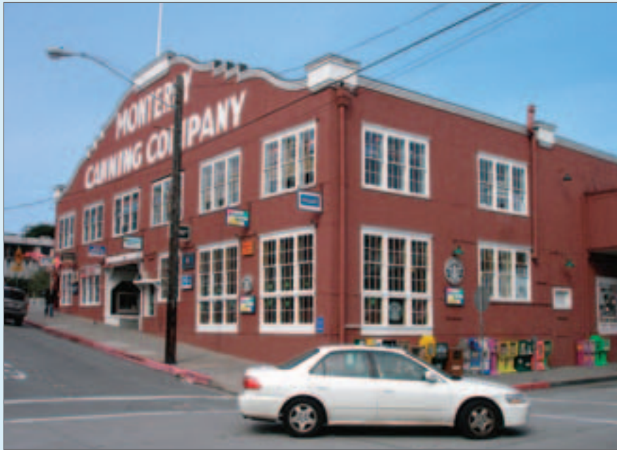
▲ 蒙特雷市街上紅色泥磚建築罐頭工廠，印證昔日繁榮景象。
