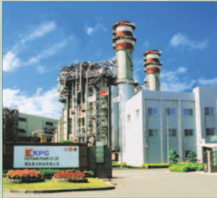
▲ 中油轉投資事業國光電力公司所屬國光電廠。
