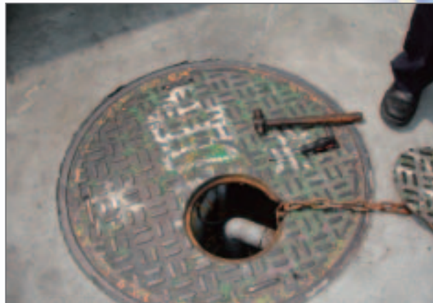
▲ 小小的創意、大大的發揮，讓油槽變水槽。（攝影：楊靜萍）
