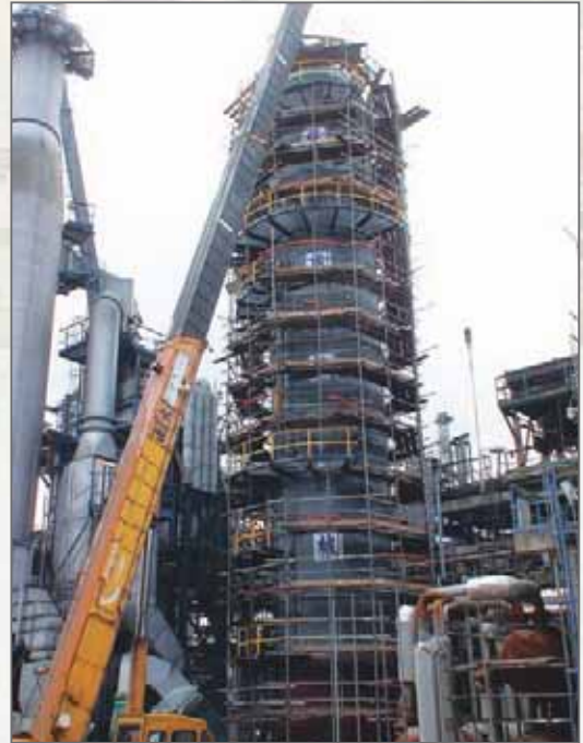
▲ 桃園廠第二柴油加氫脫硫工場反應器安裝（時間為96年12月21日及27日）。此一煉製結構改善工場已創下驚人利潤，更代表在國內柴油10wppm之新規範時程上，不落人後，及時趕上。
