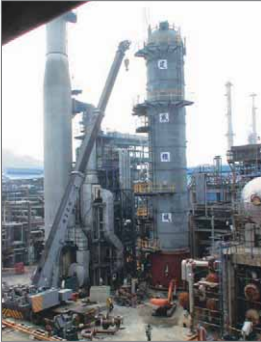
▲ 桃園廠第二柴油加氫脫硫工場反應器安裝（時間為96年12月21日及27日）。此一煉製結構改善工場已創下驚人利潤，更代表在國內柴油10wppm之新規範時程上，不落人後，及時趕上。
