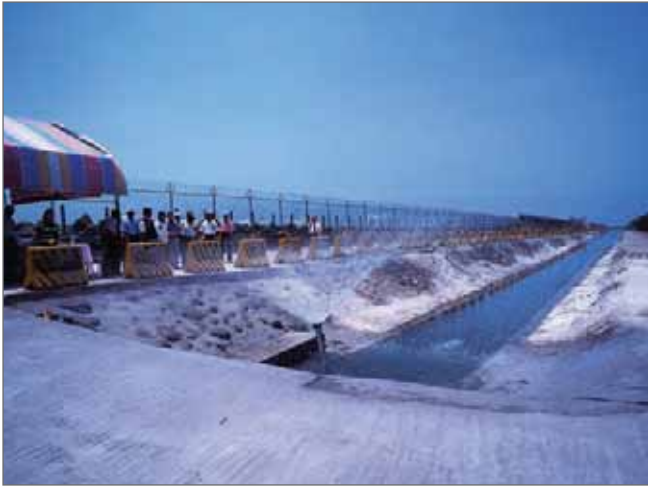
▲ 永安廠南側門外冷排水引水渠道。
