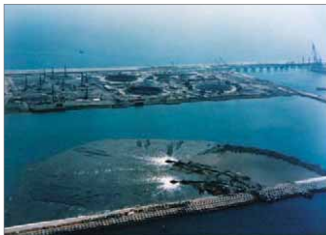
▲ 本公司配合政府能源多元化政策，73年2月奉行政院核定於高雄縣永安鄉新港村海濱填海造陸興建台灣首座LNG接收站。
