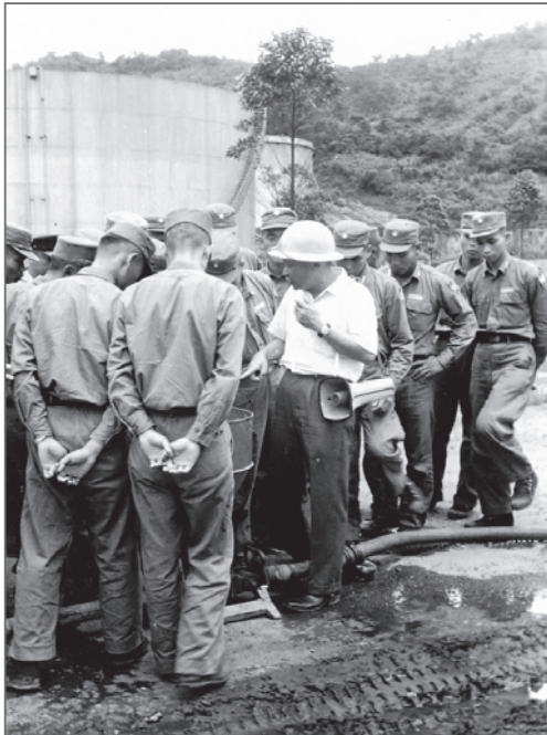
▲ 參觀油槽固定式泡沫消防設備。
