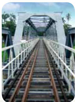
▲虎尾鐵橋的獨特鋼樑工法，令人讚嘆。
