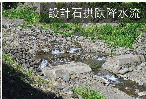
固床工開口營造低水流路
