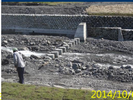
低落差固床工與砌石護岸
