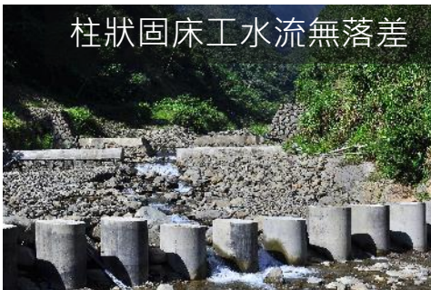
固床工開口營造低水流路
