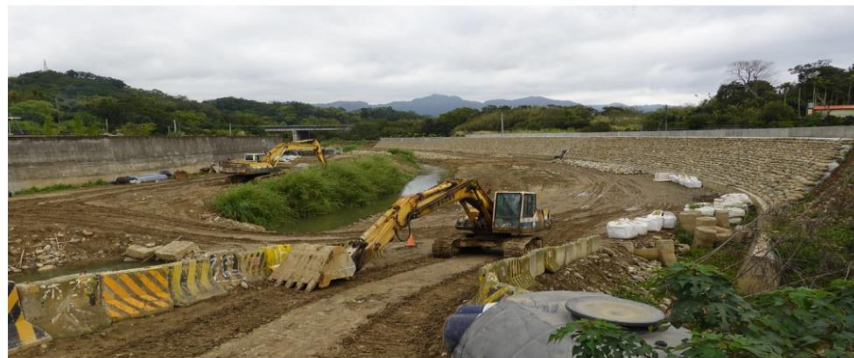
沙河溪正在進行橋樑改建及河川整治工程，卻未將瀕危的一級保育類「飯島氏銀鮐」納入生態檢核。攝影：孫文臨
