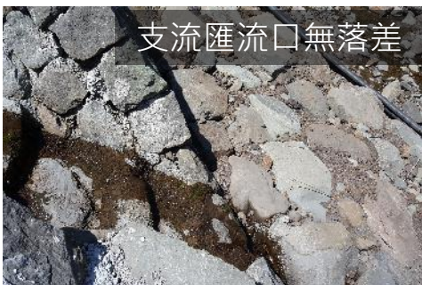
柱狀固床工水流無落差
