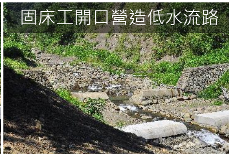
柱狀固床工水流無落差
