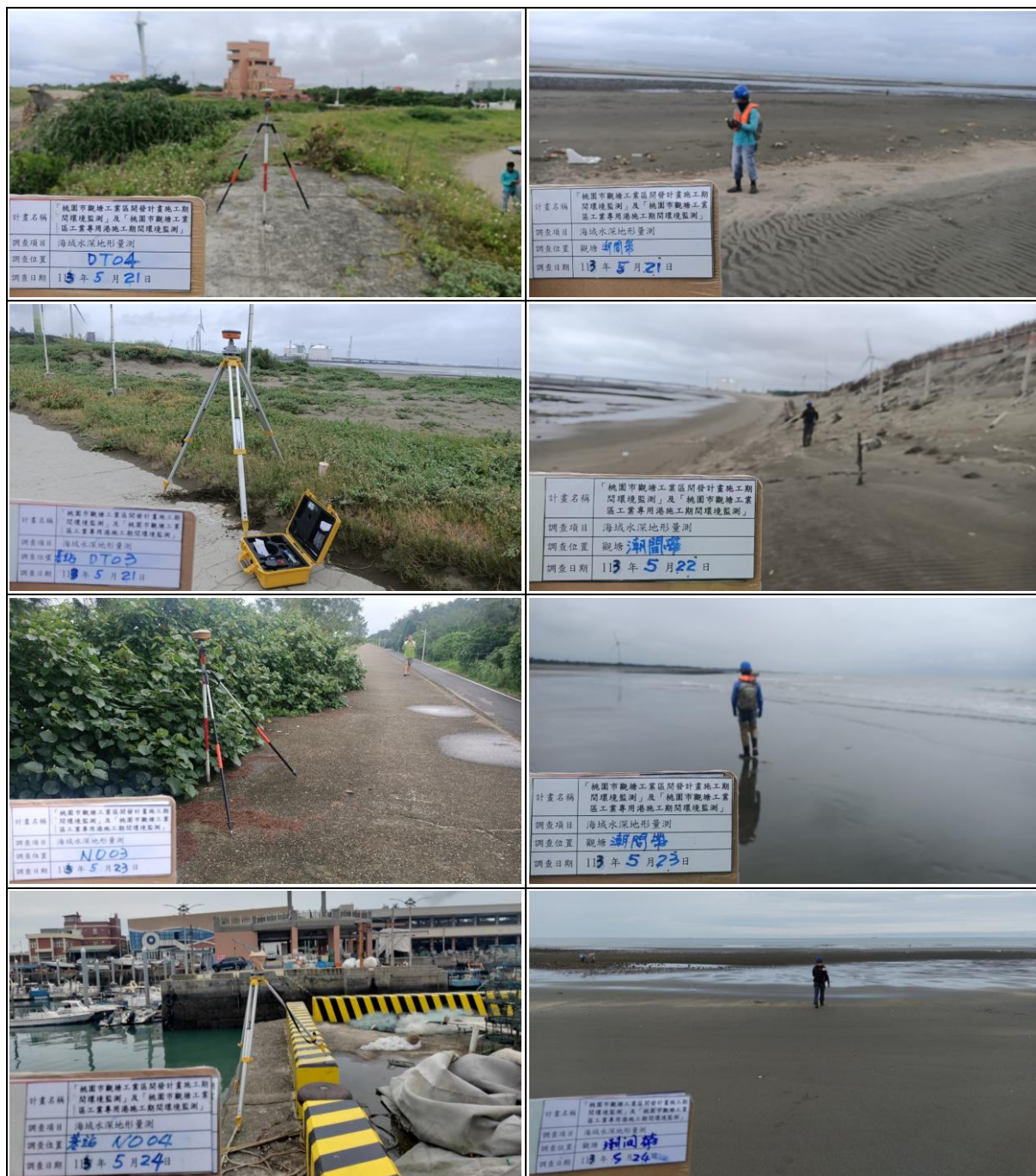
圖 2.12.1-2 陸域地形調查現場作業相片
