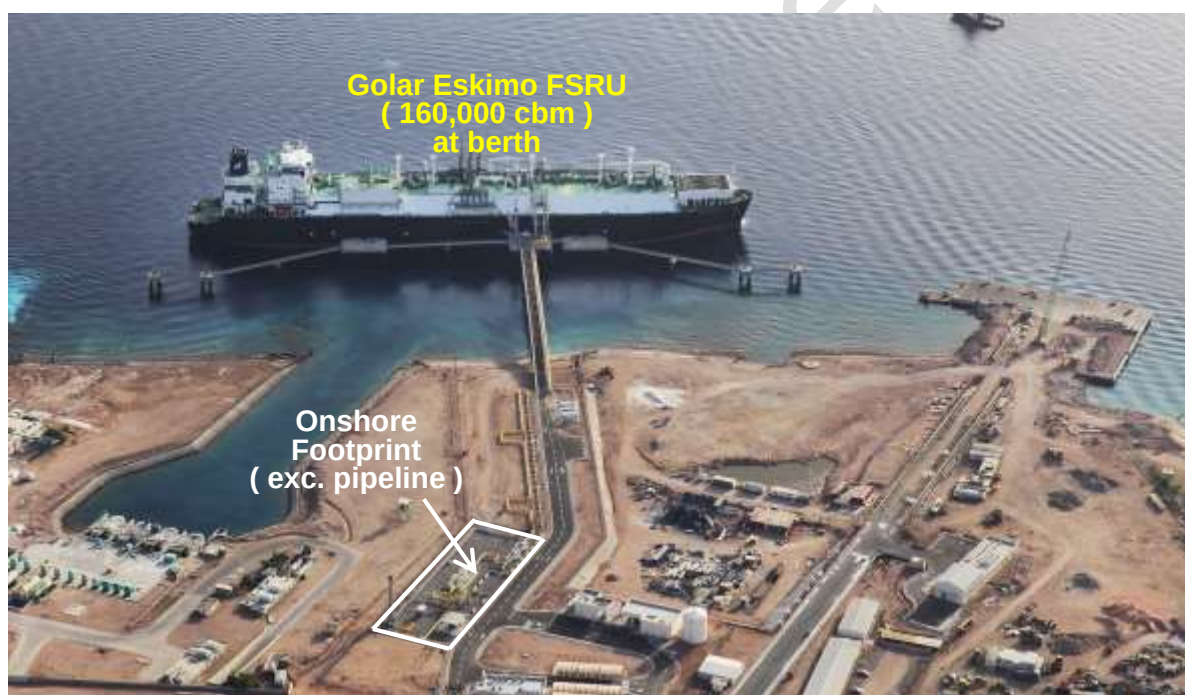
圖 7-27：FSRU 專案陸上區域案例（Aqaba FSRU）
