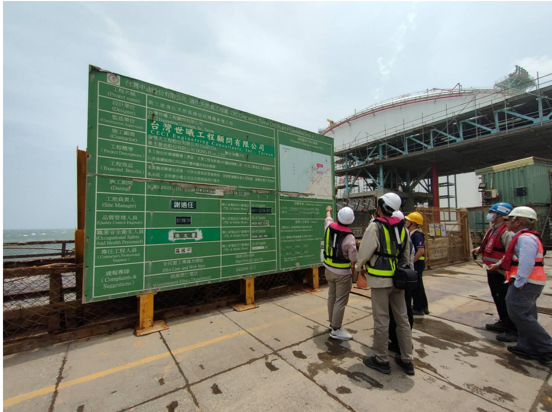
觀塘三階工程現勘
