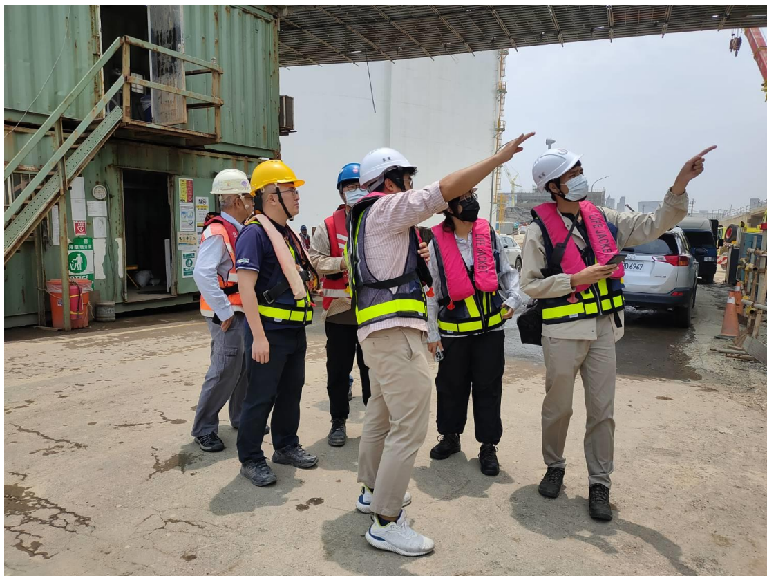
觀塘三階工程現勘
