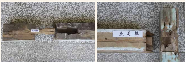
▶此2棟歷史建築常用到的榫接方式： 型壁榫、蛇頭榫、燕尾榫
