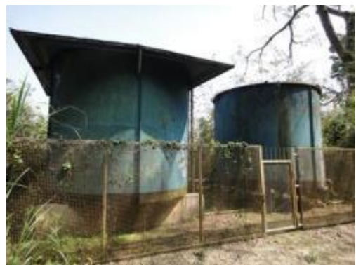
南寮水泵房現況圖
