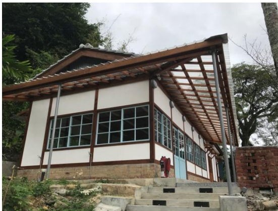
歷史建築舊醫務所現況圖
