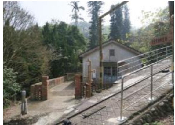
歷史建築舊重機具維修庫現況圖
