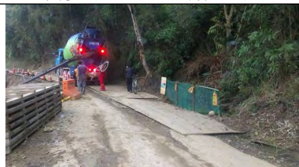
環境一樣點B道路工程，水泥灌漿
