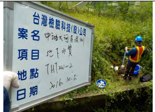
監測項目：地下水質 監測日期：105.10.05 監測地點：THT2W-2
