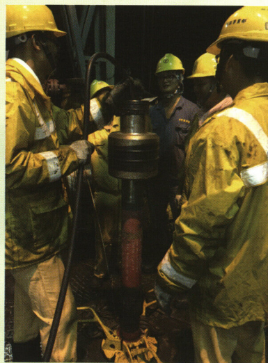
圖三、安裝油管掛並試壓
