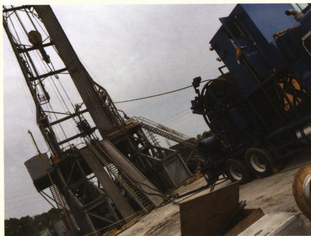
圖五、組立撓曲油管設備
