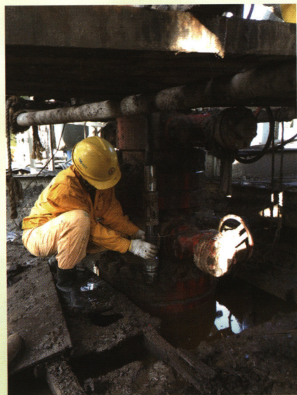
圖六、以撓曲油管取出油管内止回閥
