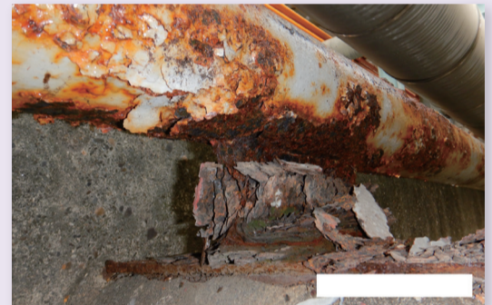
▲圖四、管線包覆拆除後。
