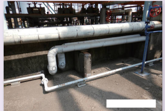
▲圖三、管線包覆拆除前。
