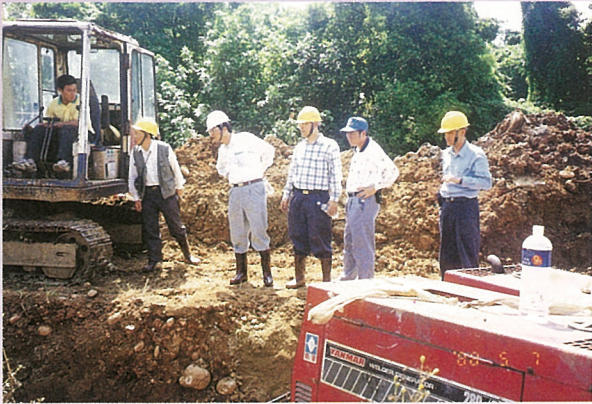
戴總處長蒞臨現場瞭解施工狀況（照片由馬副處長提供）
