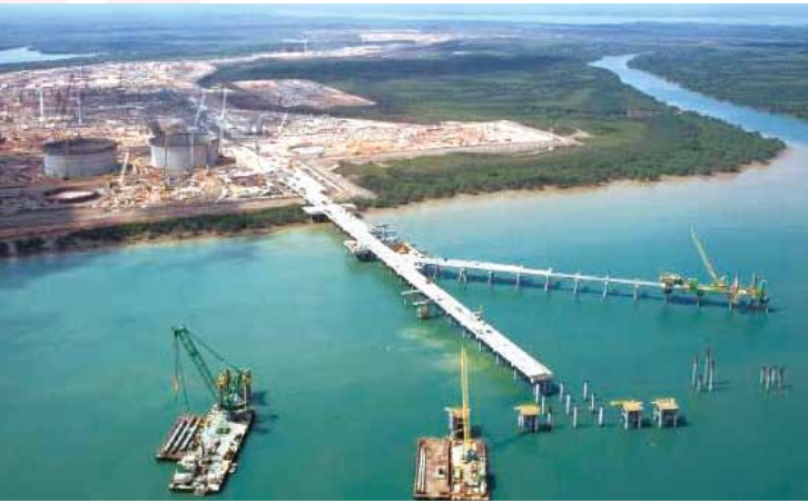
▲依序思案陸上液化天然氣廠工程進度空照圖。
