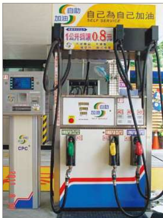
▲ 100年度改良式自助加油機（外置式自助加油機）。（攝影：陳俊宇）
