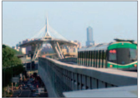
▲ 如飛鷹展翅的世運站，可俯瞰高廠及宿舍區。
