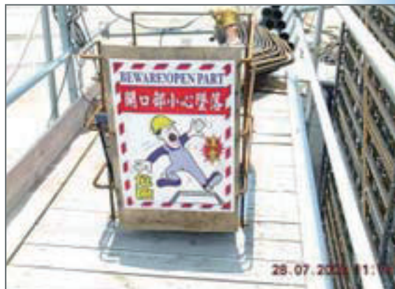
▲ 現場工安警示，善盡危害告知。 (攝影：吳錦傳)
