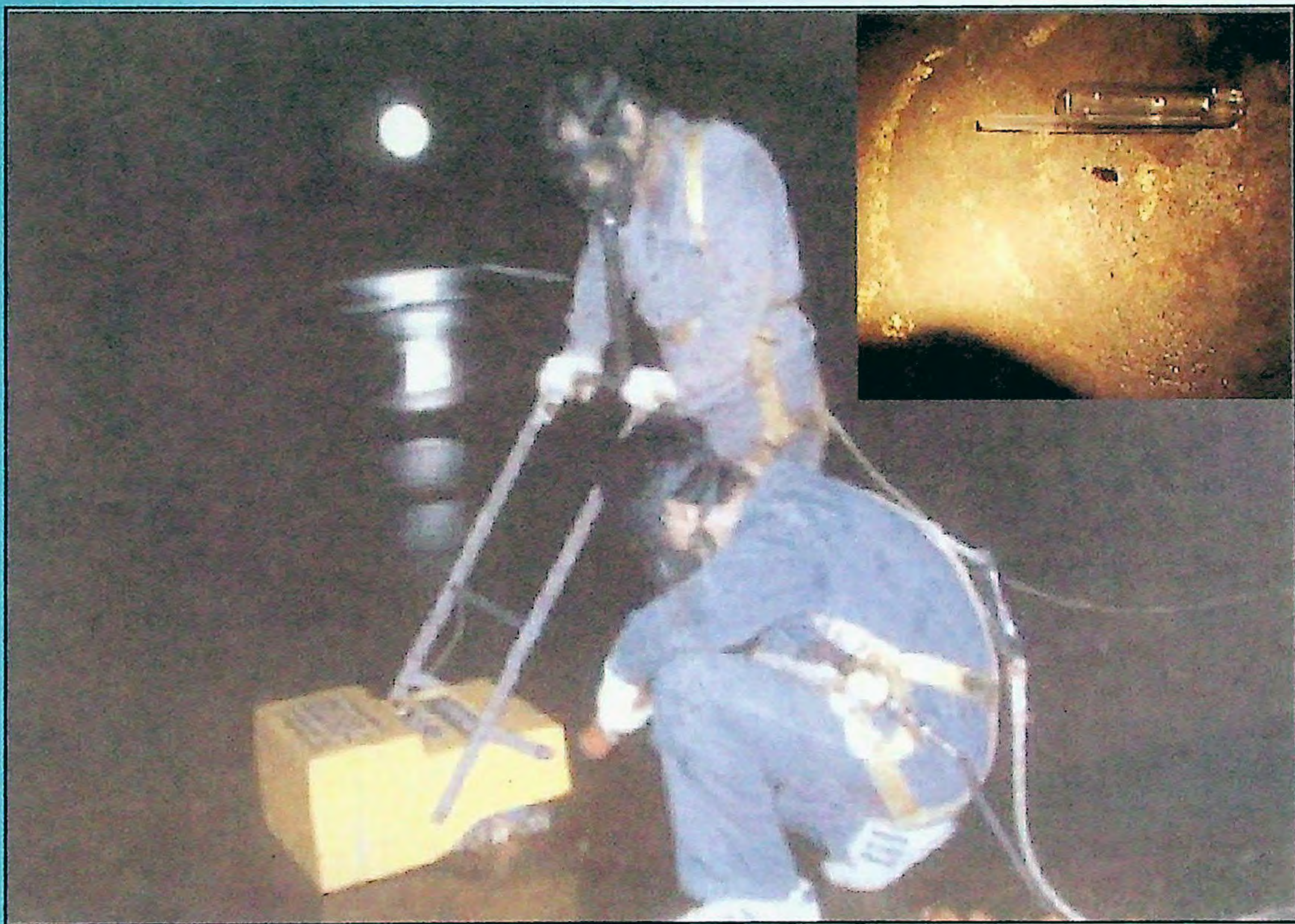
▲ 底板磁漏檢測及檢出的漏孔。
