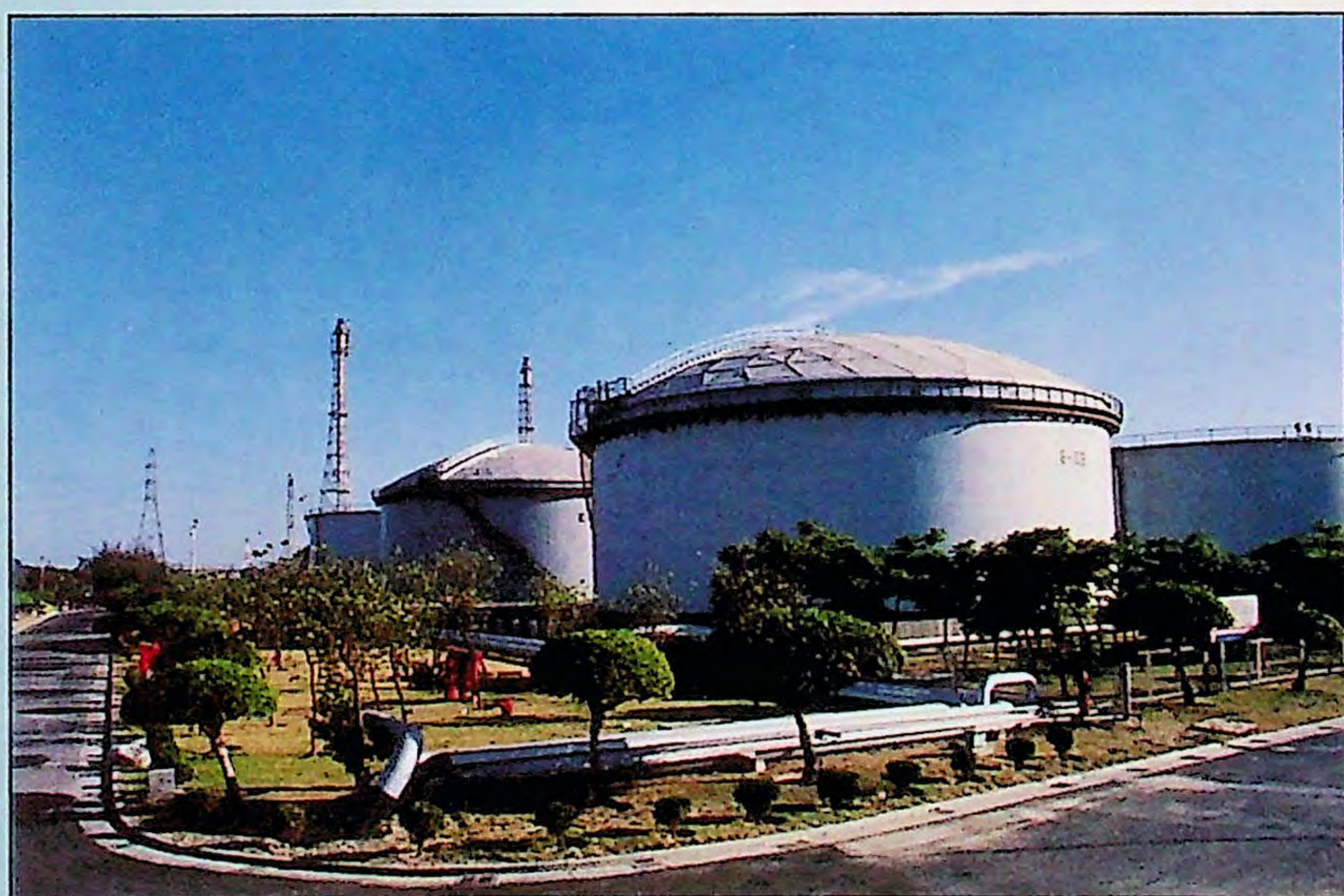
▲ 浮頂油槽（右一為外浮頂油槽，右二、右三為內浮頂油槽）。
