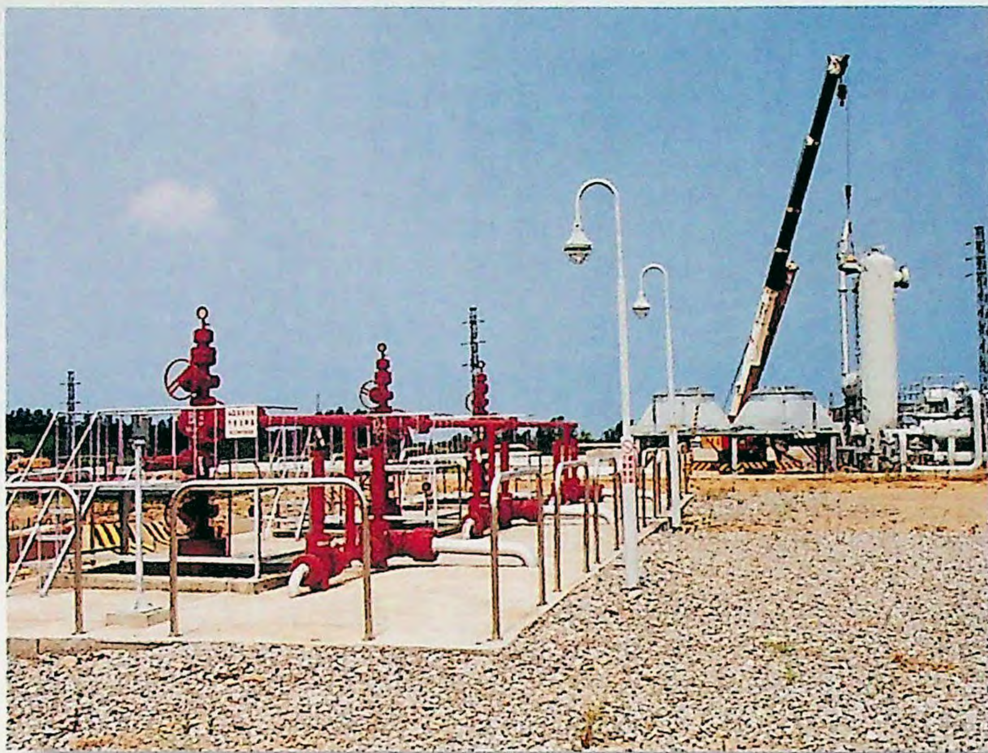
▲ 天然氣注產氣工程。
