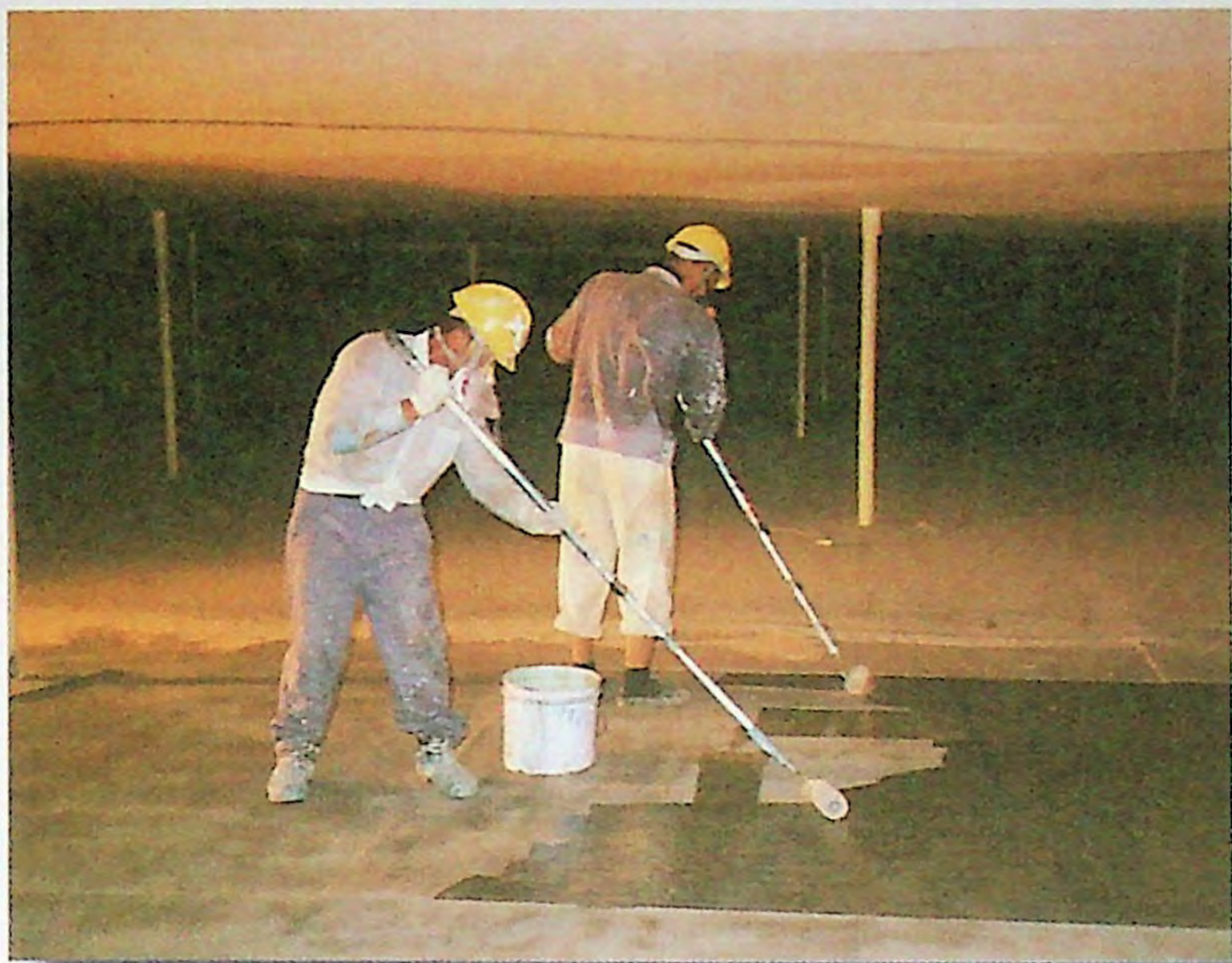
▲ 塗料事業所同仁進行油槽內襯作業。
