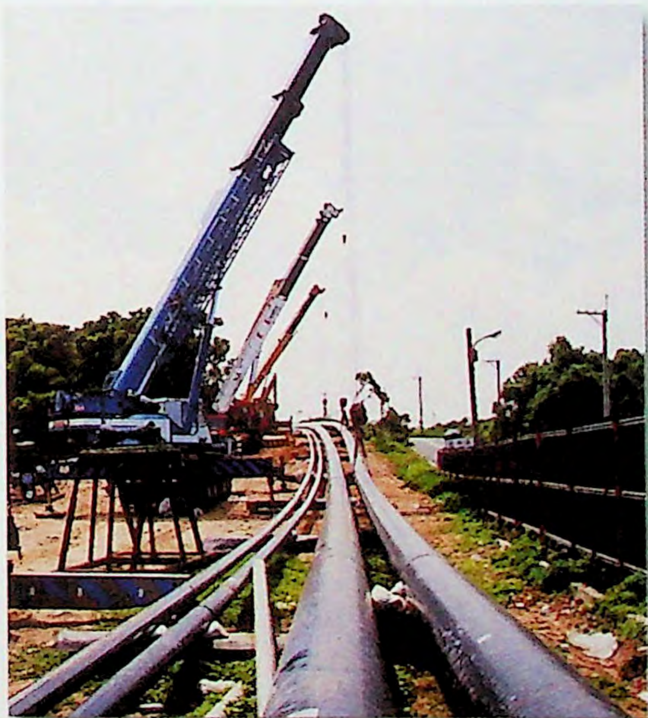
▲ 管線敷設工程。
