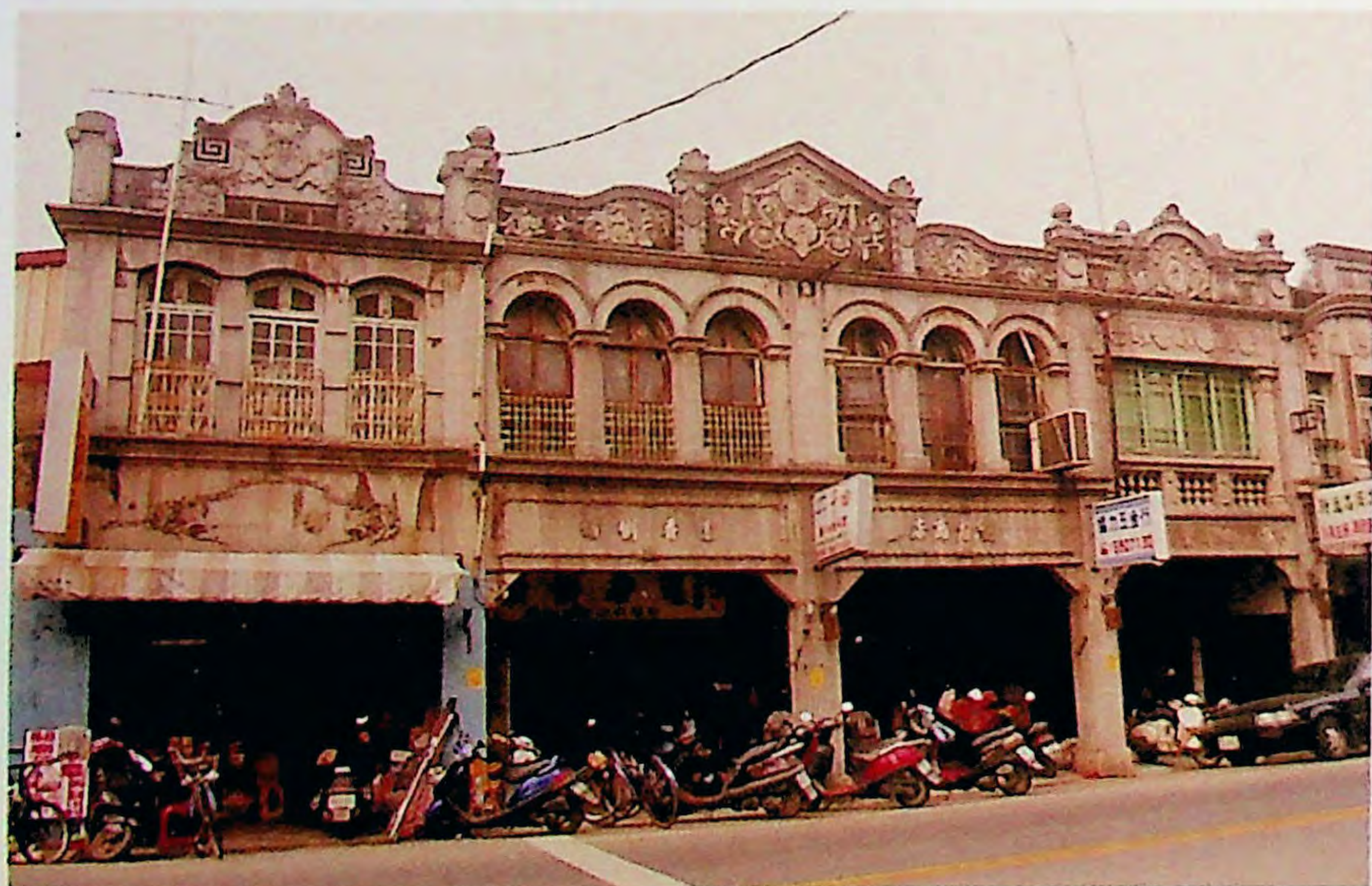
▲ 新化老街保存十八世紀「巴洛克」建築風貌。
