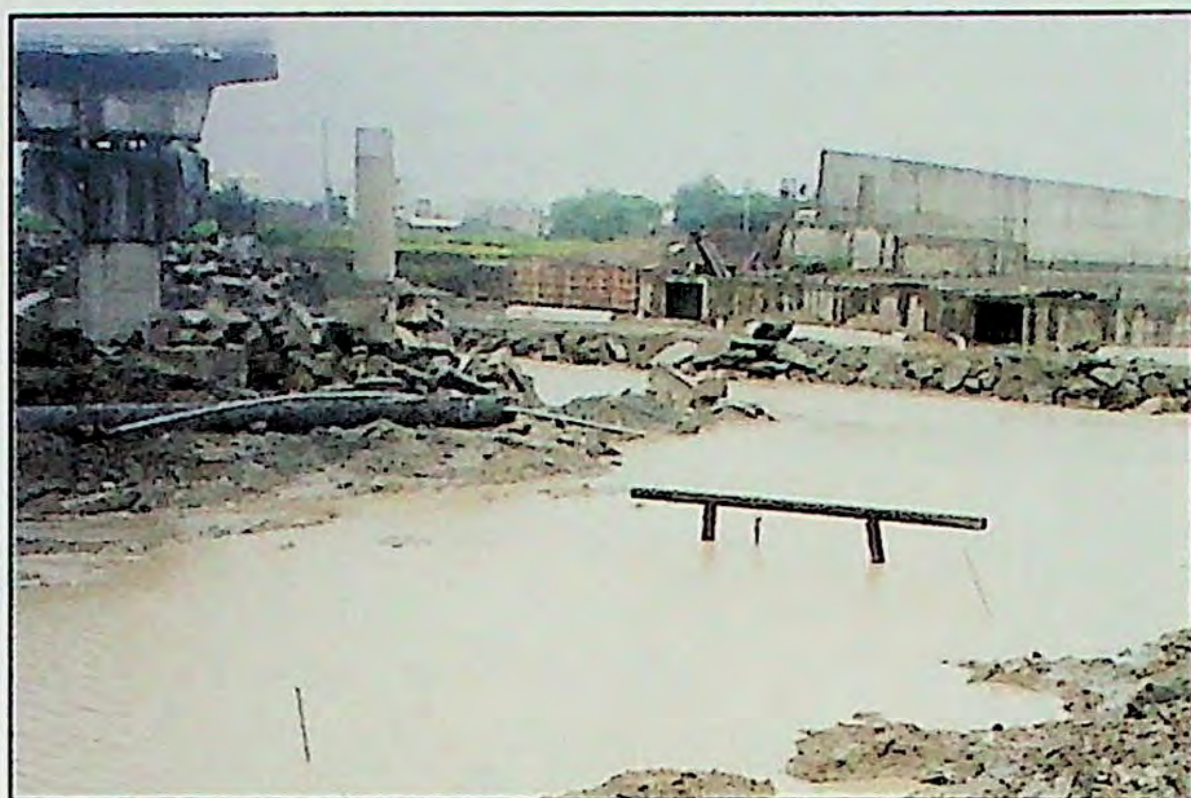
▲ 溪水暴漲淹沒管溝
