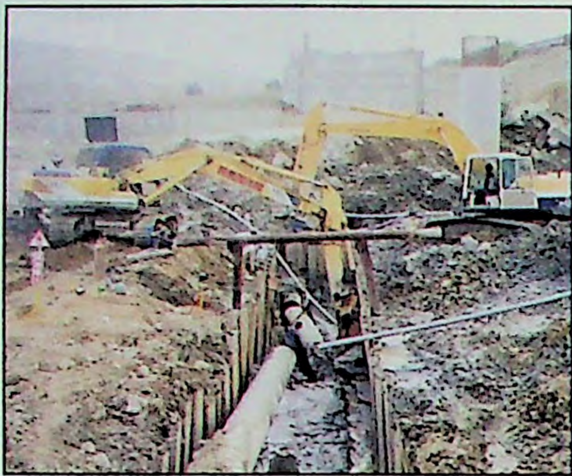
▲ 新舊管銜接點施工情形
