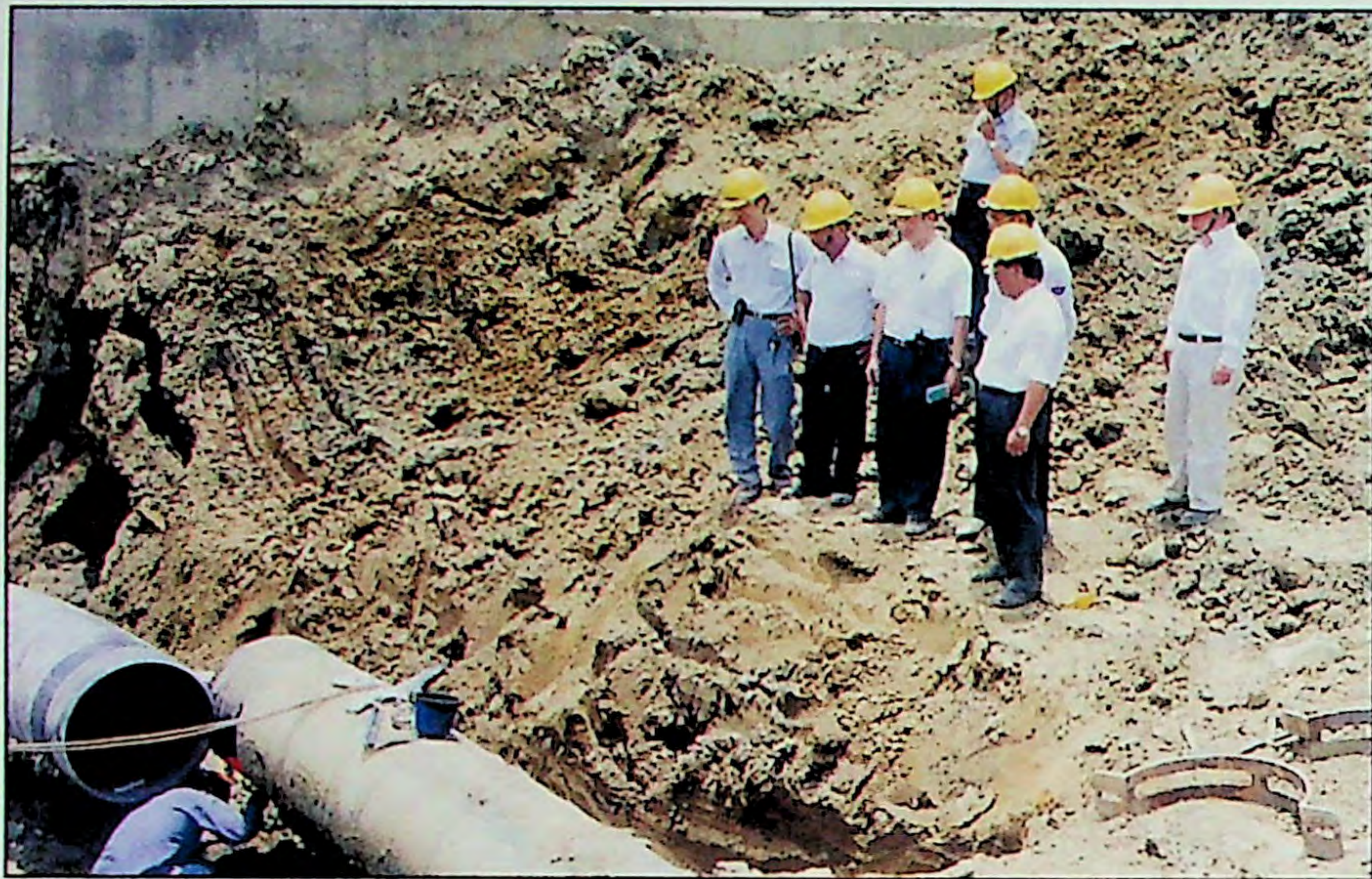
▲ 嘉南營業處黃正雄處長視察工地
