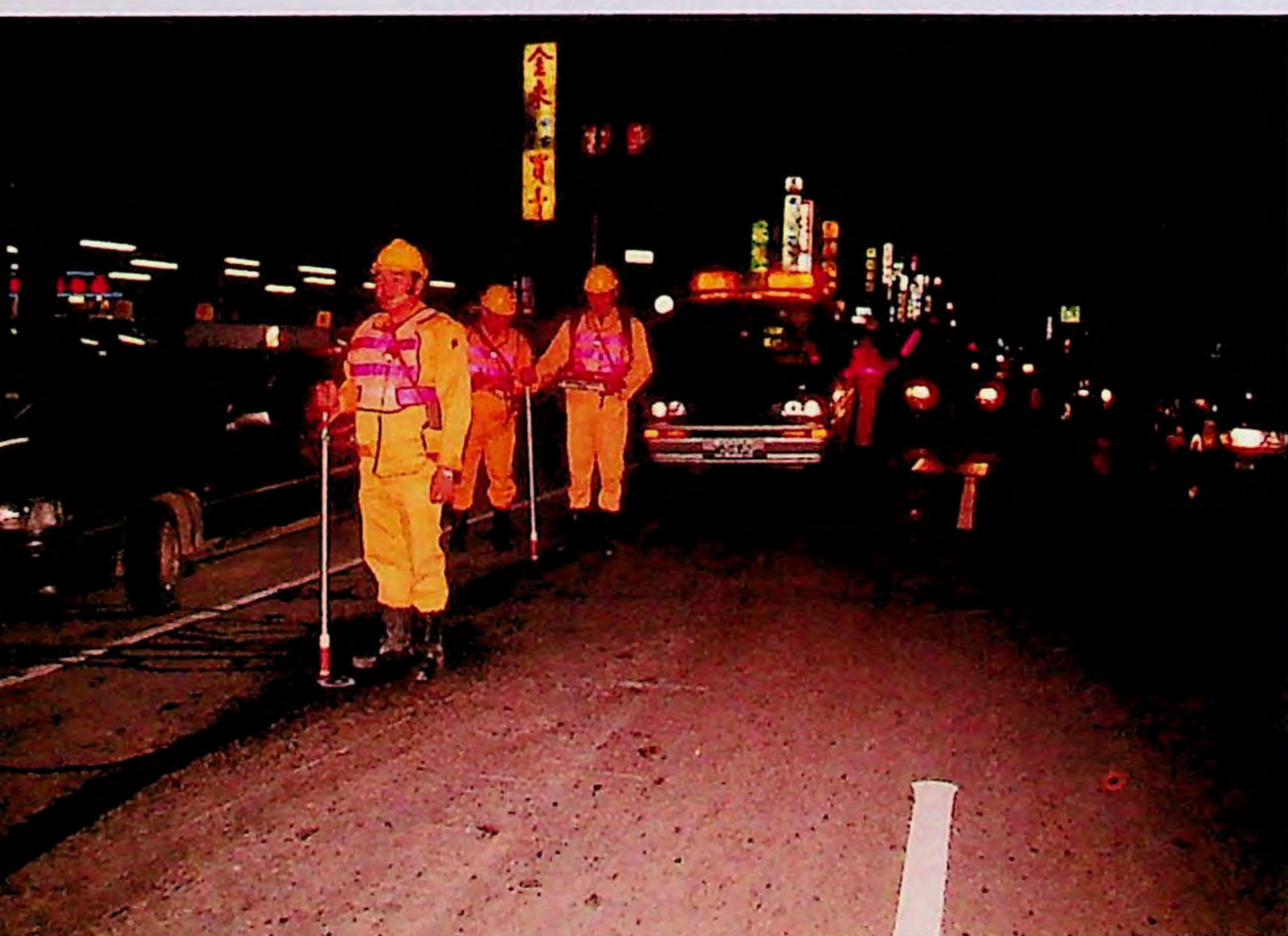
◀ 檢測隊員於夜間在車陣中執行 管線緊密電位測量作業。
