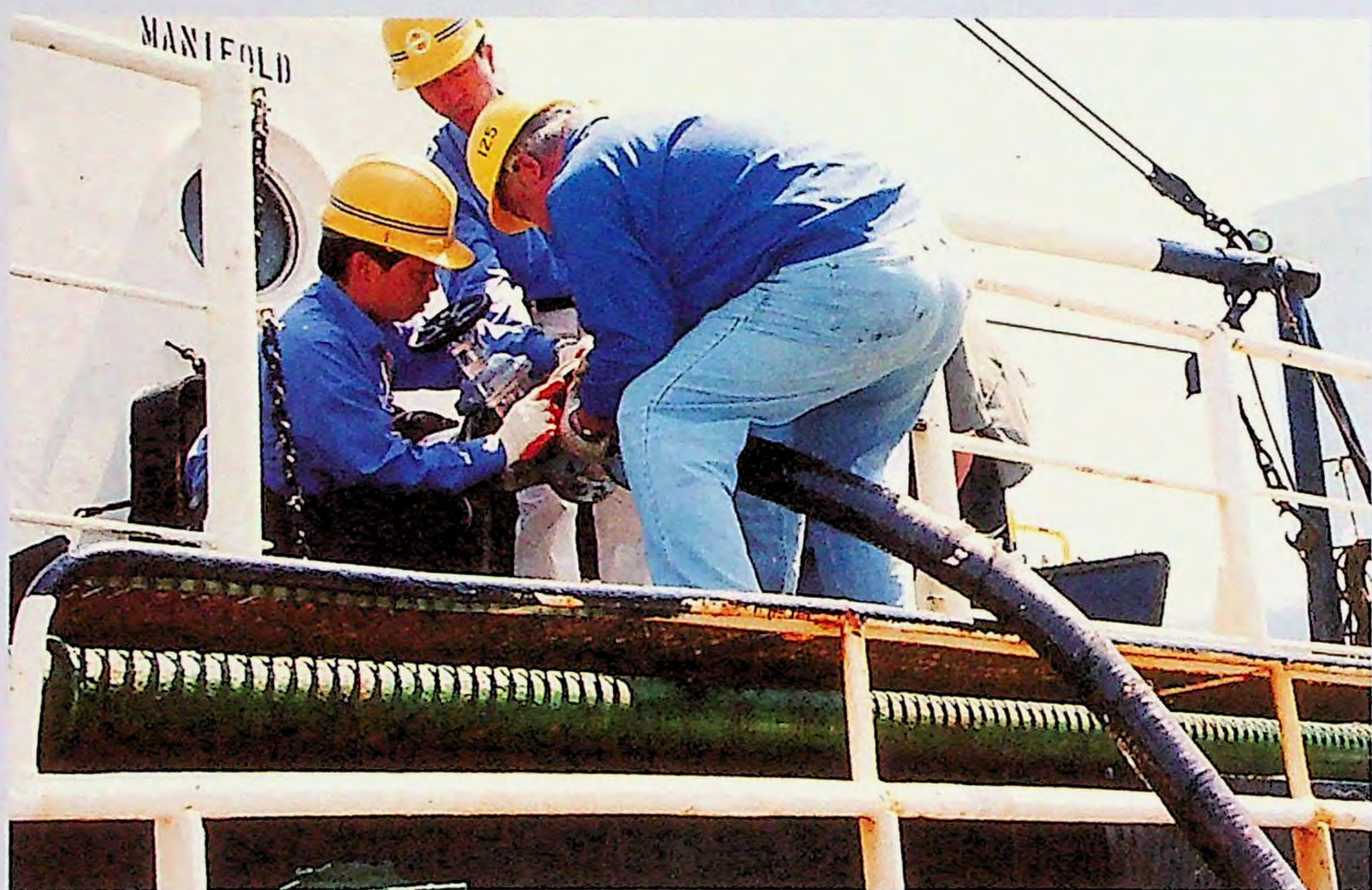
▶ 工作人員正進行輸油管聯結作業。
