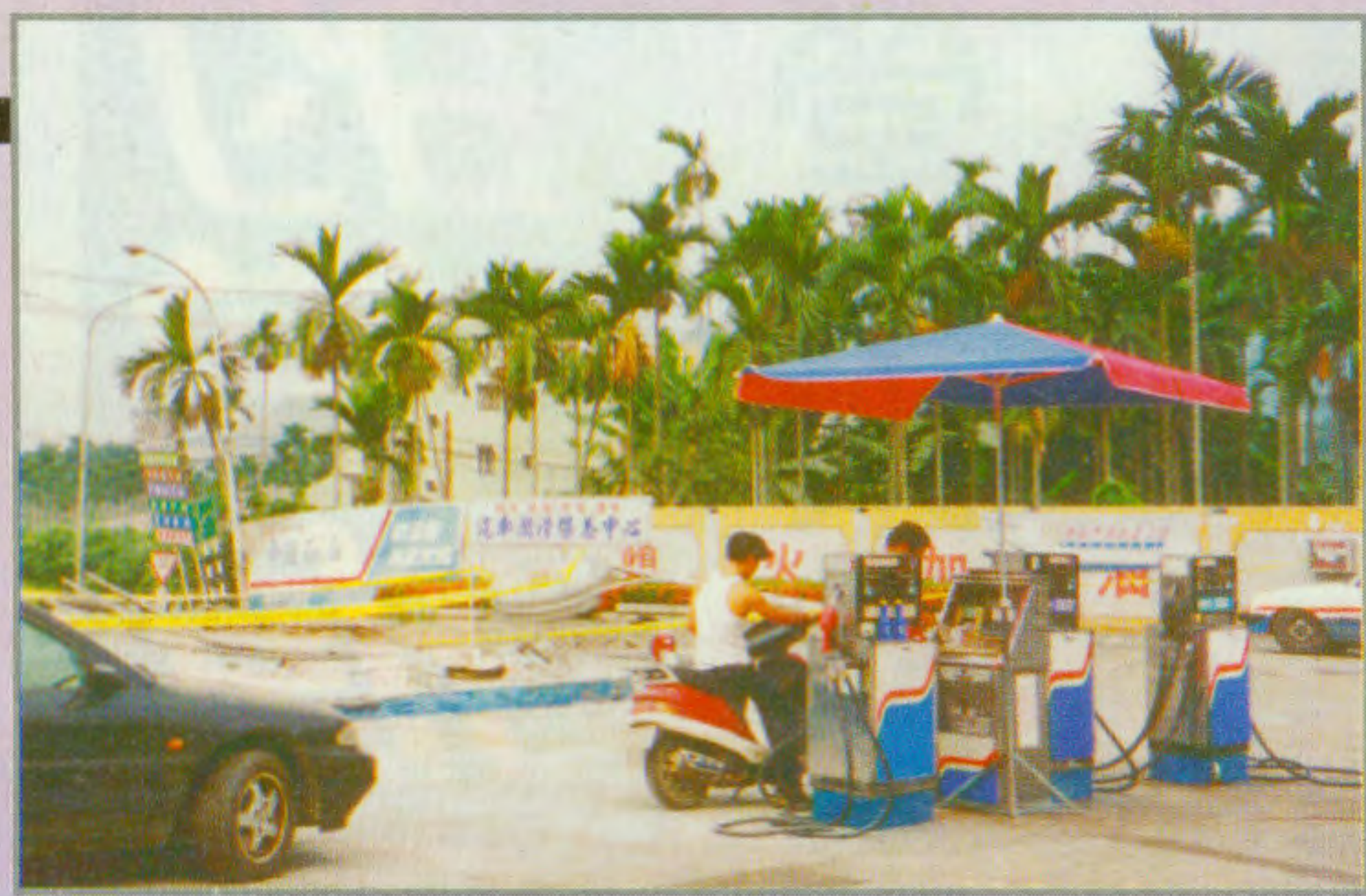
竹山延平加油站因九二一大地震餘震而傾倒。站上同仁化憂懼為力量，齊心重建，在最短時間內恢復營業，露天加油，充分發揮「愛站如家」精神，更鞏固了行銷據點。
